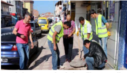
Telekom, Şarkışla'ya fiber optik kablo döşüyor
