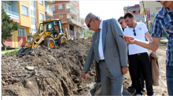
Suşehri Belediyesi yol genişletme çalışmaları
